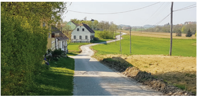
V prihodnjem mesecu se bo pričela sanacija 1500 m dolgega cestnega odseka v Zg. Partinju - odsek Široko.
