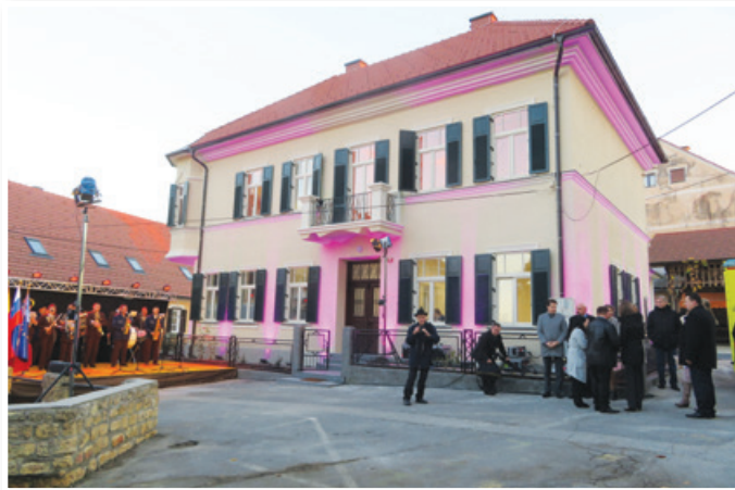
Prostori zdravstvene ambulante so v najlepši zgradbi na Trojiškem trgu v središču Svete Trojice, ki so jo lani energijsko prenovili.
